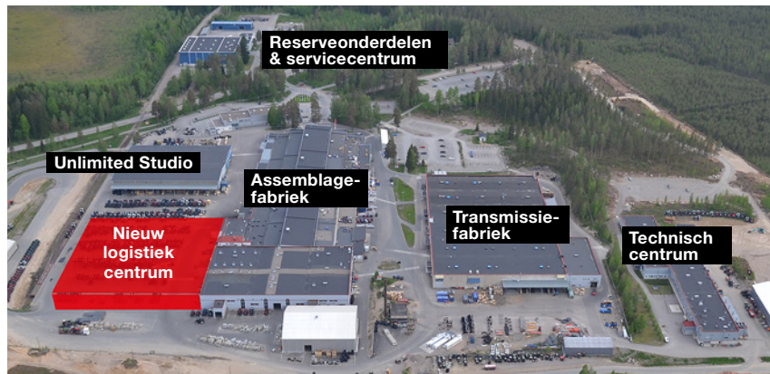
Het nieuwe logistieke centrum van 8.000 m 2 wordt gebouwd op het terrein tussen de assemblagefabriek en de Unlimited Studio.
